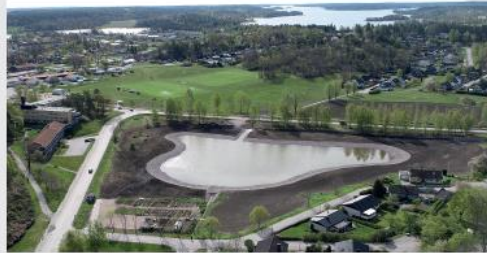
Bild 1 Beispiel Vasterik (Schweden): Ein Regenrückhaltebecken auf Granleby wird aus einem 10 ha großen Einzugsgebiet gespeist und dient der Bewässerung städtischer Flächen. Quelle: Andrijauskas
