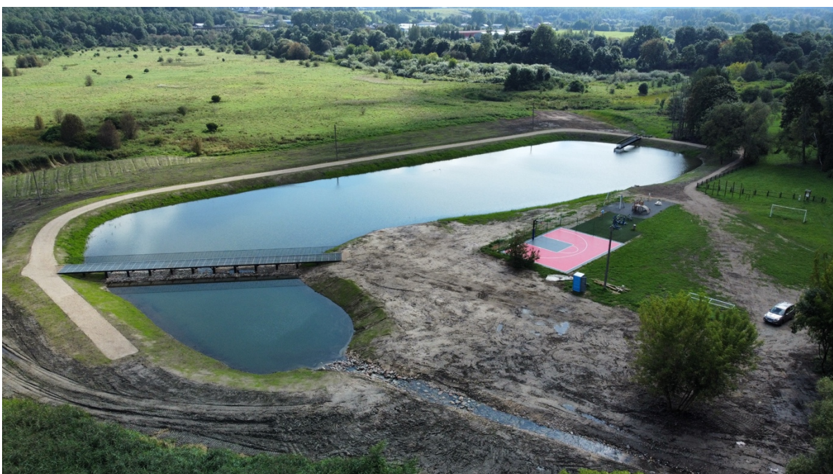
97. attēls. Izveidotais lietus ūdens uzkrāšanas dīķis (avots: Vytautas Valantinas, Klaipėda District Municipality).
