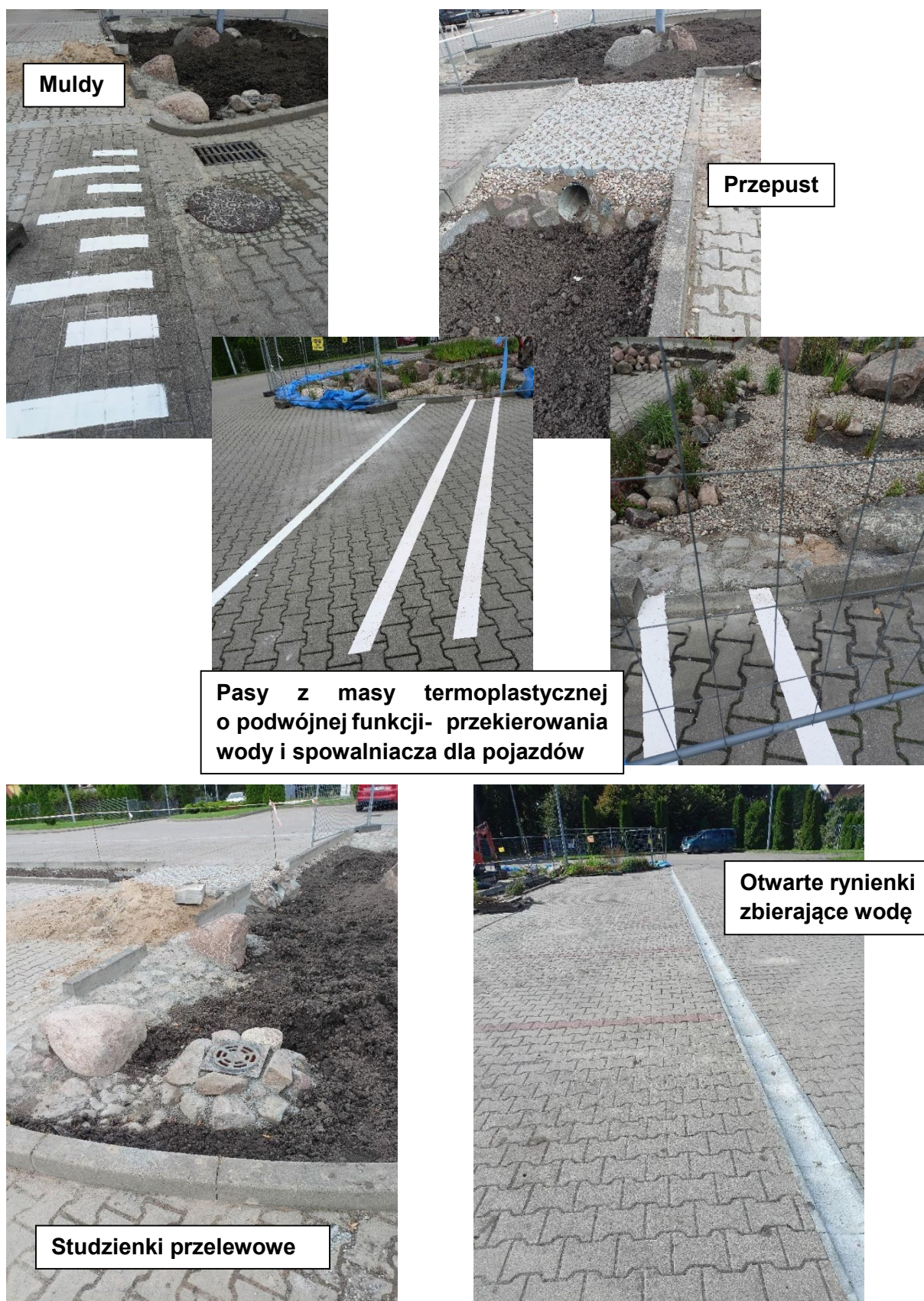
Rys. 5.24. Zdjęcia z realizacji prac budowlanych (autor: Urząd Miasta Braniewa)
