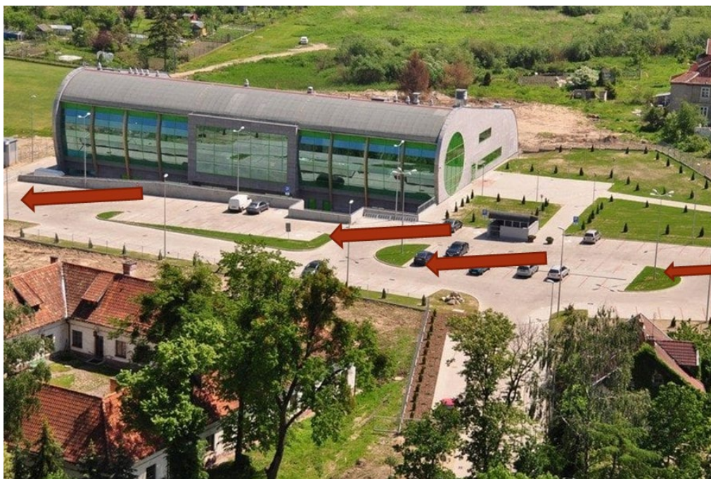
Rys. 5.14. Schemat wstępnej inwentaryzacji terenu oraz ocena możliwości grawitacyjnego doprowadzenia wód opadowych z terenu wokół MOS Zatoka w Braniewie
