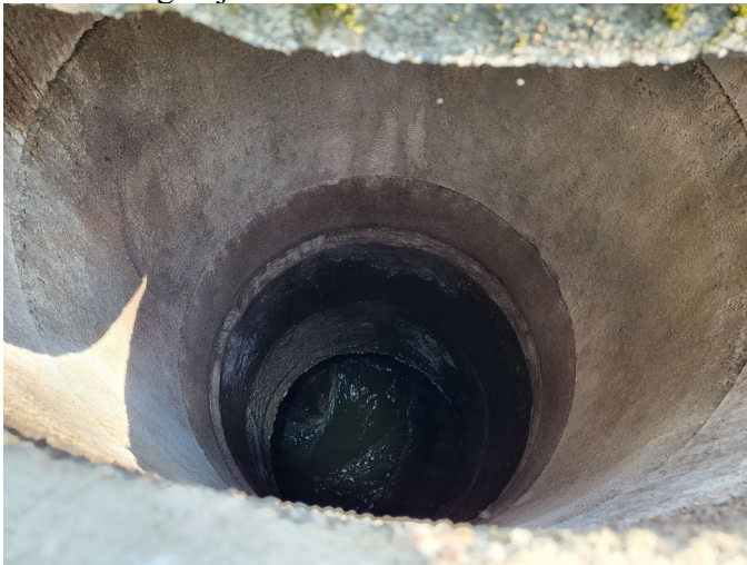
Bild 10: Inloppsbrunn (betong)
