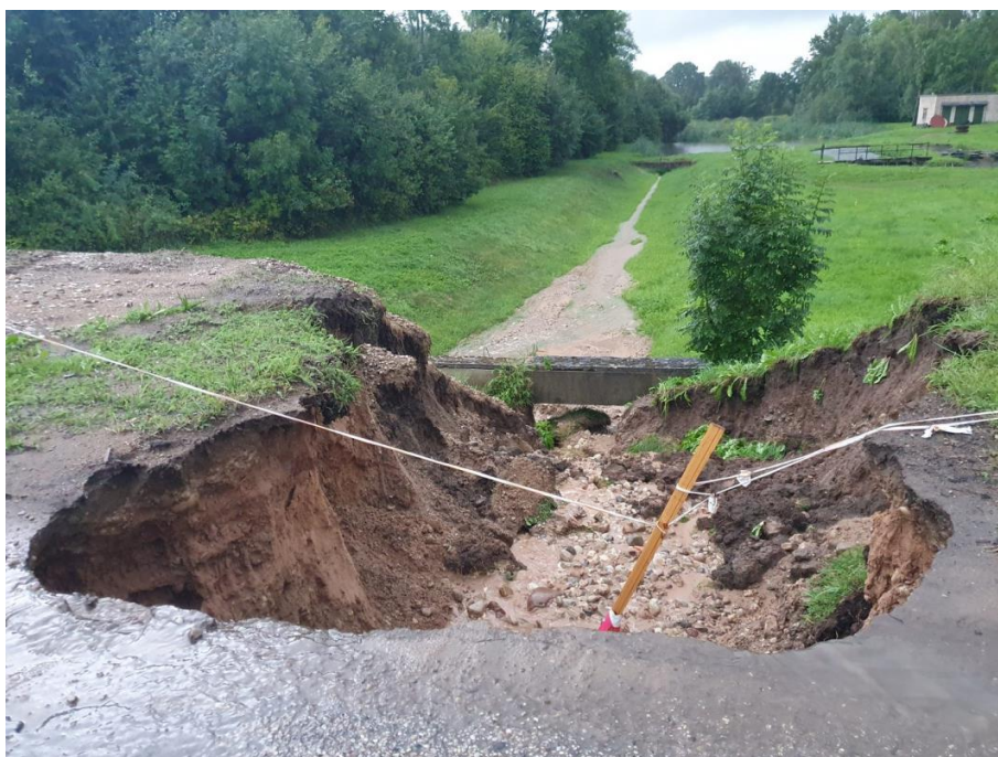
63. attēls. Izskalots ceļš Tukuma novadā (avots: Neatkarīgās Tukuma ziņas).
